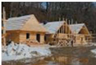
Budynki w trakcie budowy
