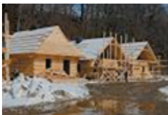
Budynki w trakcie budowy
